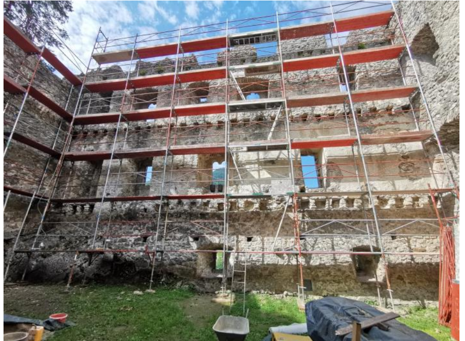
Hier ein Foto des eingerüsteten Palas zur Ertüchtigung der Mauerkrone im Zuge der vom Land OÖ 2024 durchgeführten Sanierungsarbeiten.
